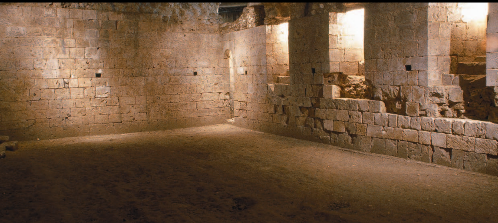
L'angle nord-ouest et l'entrée de la tourelle d'escalier.
