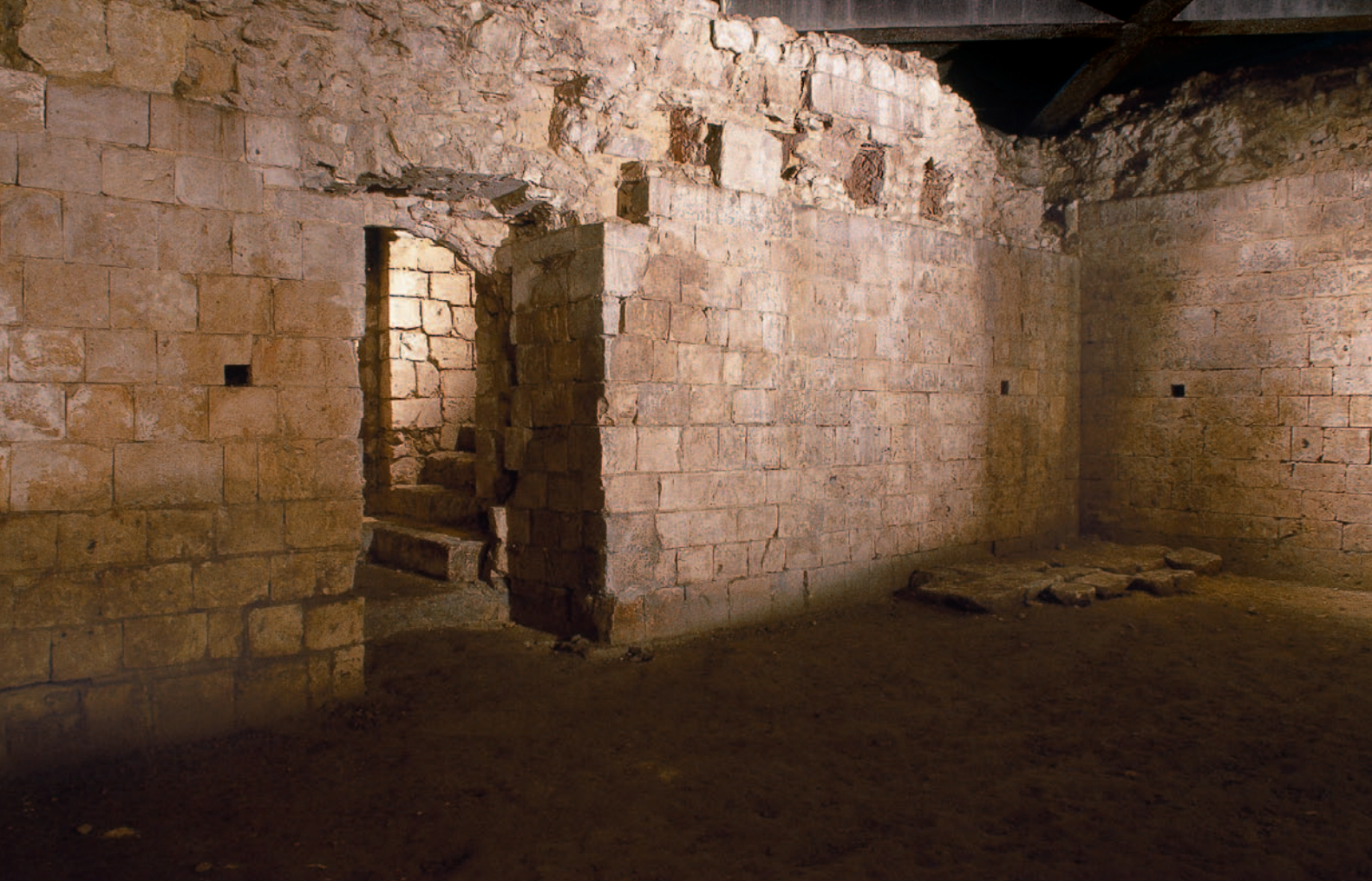
L'entrée sud dans la salle basse.
